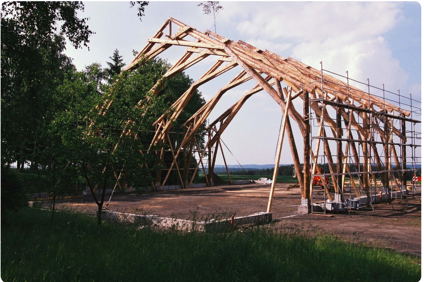
2007, Bau der Großen Festspielscheune
